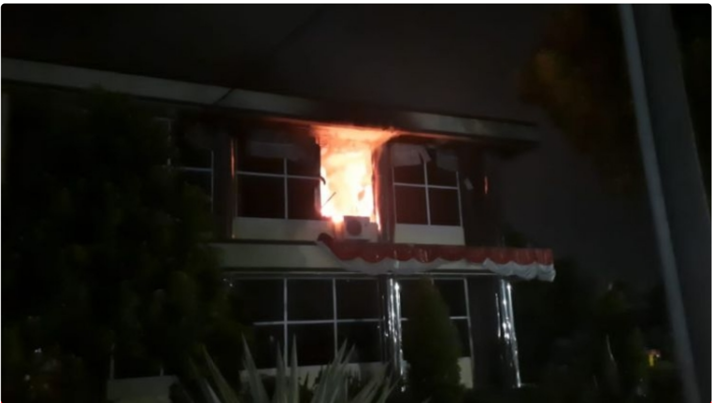
Diduga arus pendek, Gedung Ditreskrimsus Poldasu Terbakar, Kamis (25/8).
